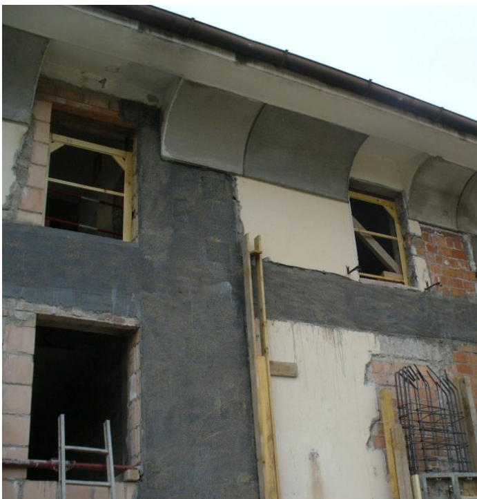
Immagine 15: Fasciatura di piano con CFRP.
