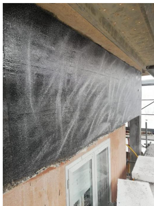
Immagine 7: Rinforzi fasce di piano con CFRP.
