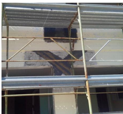
Immagine 4: Rinforzo nodi trave – colonna con CFRP.
