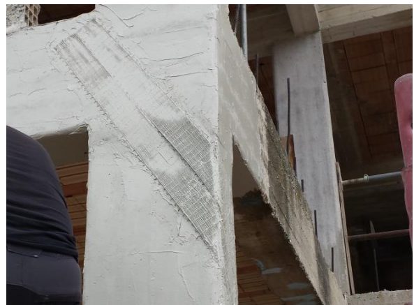
Immagine 5: Rinforzo nodi d'angolo con CFRP.
