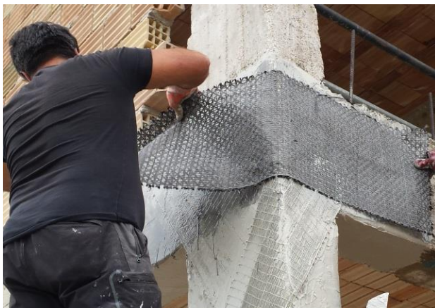
Immagine 5: Rinforzo nodi d'angolo con CFRP.
