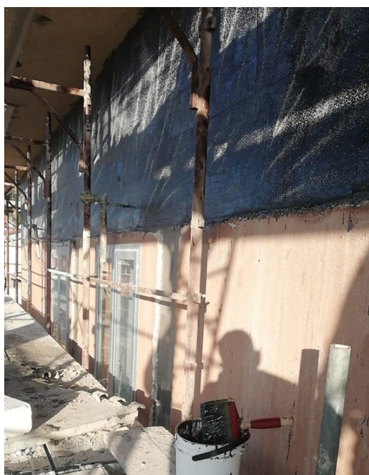
Immagine 7: Rinforzi fasce di piano con CFRP.
