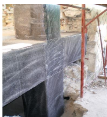
Immagine 4: Rinforzo nodi trave – colonna con CFRP.
