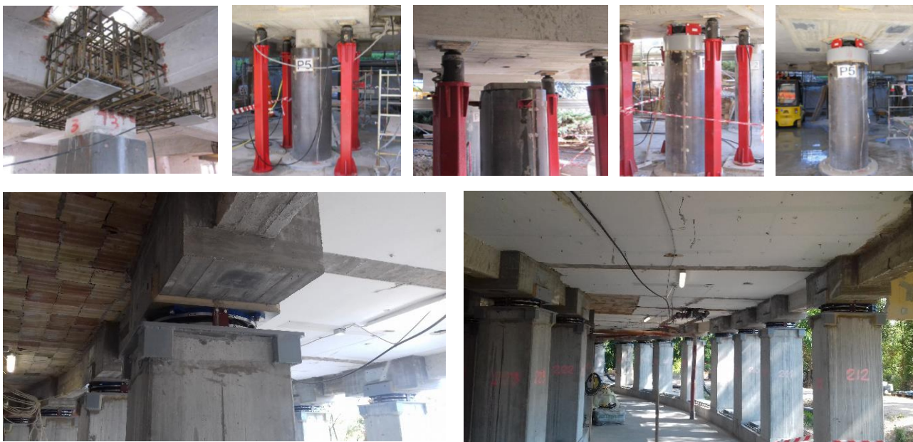
Immagine 28: Procedura d'installazione di isolatore HIRUN HP2 friction pendulum con intervento di retrofit.
